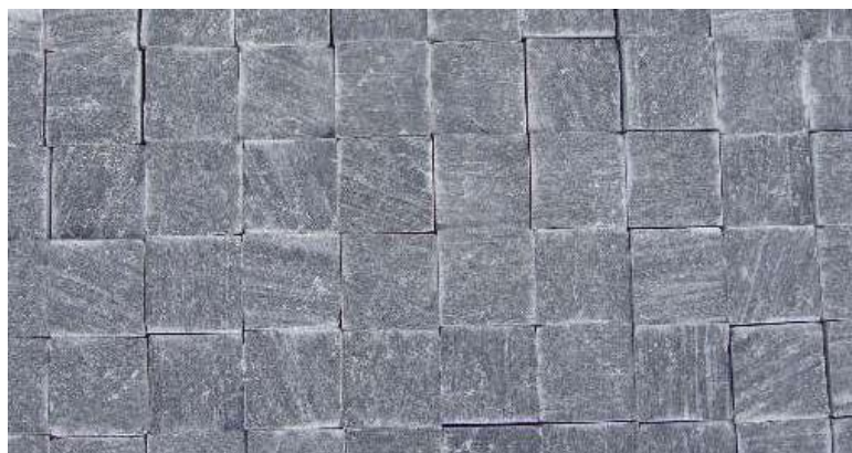
4. vazba řezané žulové kostky 40/40mm
